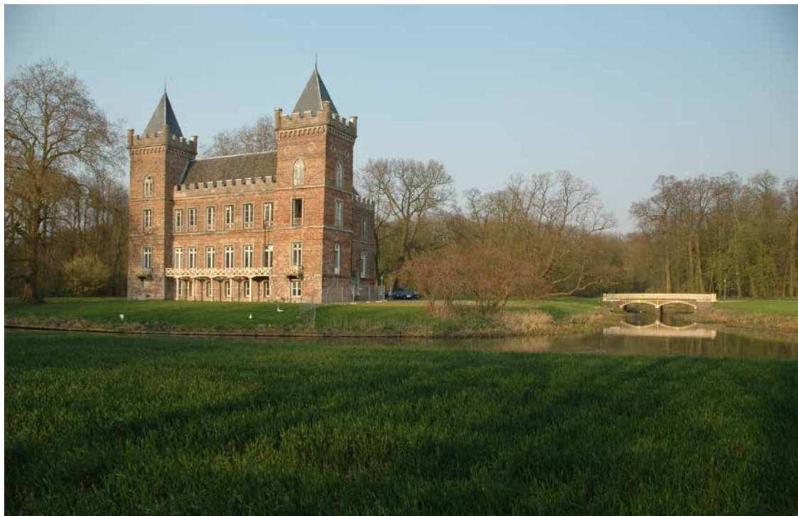
13 Kasteel Beverweerd gezien vanuit het zuidwesten, kort voor de restauratie in 2007. Het negentiende-eeuwse pleisterwerk is verdwenen met uitzondering van horizontale banden, vensteromlijstingen en daklijst met kantelen. Het houtwerk van de vensters en de smeedijzeren balkons zijn roomwit geschilderd. (foto 2007)
