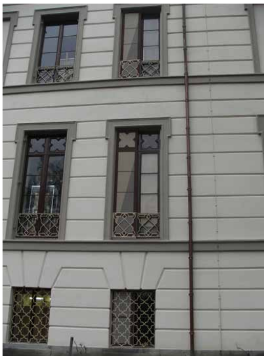
19 Gedeelte van de noordgevel na de restauratie inclusief de schijnvensters in trompe l'oeil. (foto 2009)
