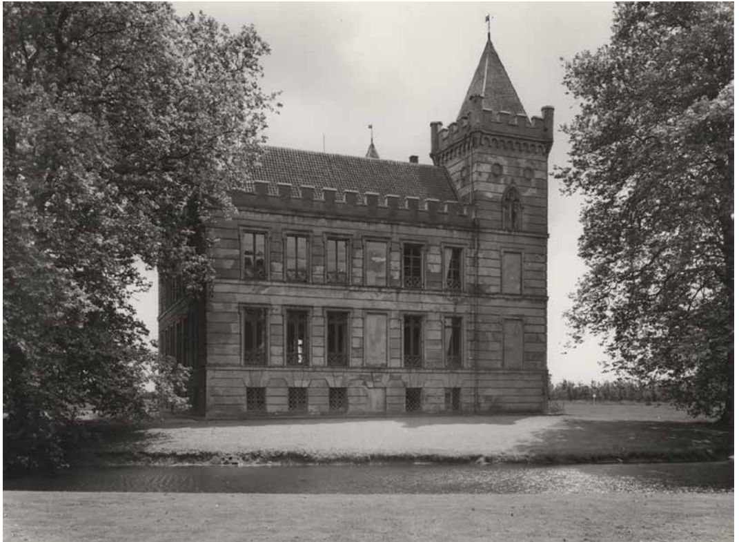
16 Gepleisterde noordgevel met in de eerste travee links naast de toren op souterrainniveau, bel-etage en eerste verdieping een vensterpartij waarvan het linkerdeel als schijnvenster in trompe l'oeil op het pleisterwerk is geschilderd inclusief het opgenomen glasgordijn en balkonhek, en het rechterdeel een echt venster is. (foto 1958, RCE 52.607)
