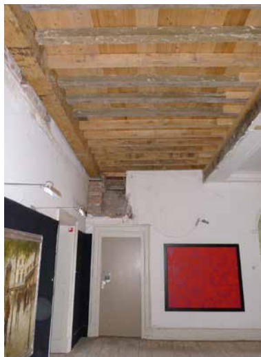
45 Interieur van de hal op de verdieping. De trap uit 1958 naar de zolder is verwijderd en de balklaag en de houten vloer hersteld. (foto 2013). Rechts: 46 Enfilade aan de westzijde van het kasteel. De naast elkaar gelegen vertrekken zijn onderling verbonden waarbij de deuren in elkaars verlengde liggen en er geen gang is. (foto 2007)
