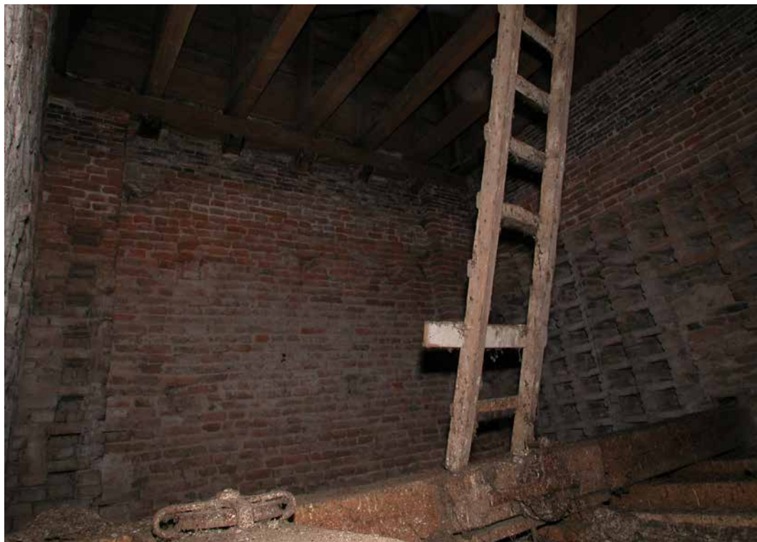
52 De vliering van de noordwestelijke toren met duivenzolder toegankelijk via een luik. Langs de wand gemetselde rekken met nestvakken. De vlieggaten zijn dichtgezet en aan de buitenzijde niet zichtbaar. (foto 2007)
