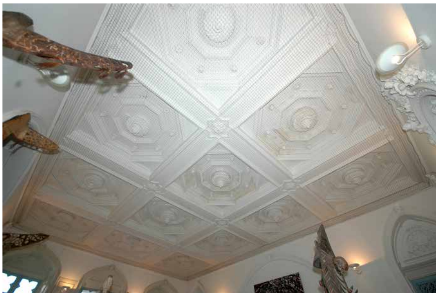
29 Het plafond in de hal op de bel-etage, uitgevoerd in twee fasen: 1836 cassettenplafond met neorenaissance ornamenten, zogeheten culs-de-lampe (laag hangend iets taps toelopen ornament) uit ca 1880. Het net onder het plafond is aangebracht om loszittende onderdelen in afwachting van restauratie op te vangen. (foto 2007)
